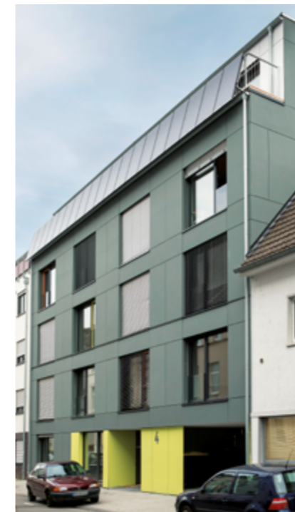
Das Gebäude bezieht seinen Strom fast ausschließlich von der Solaranlage auf dem Dach.
