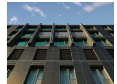
Die gewonnene Solarenergie aus der Fassade deckt den Strombedarf weitgehend.
