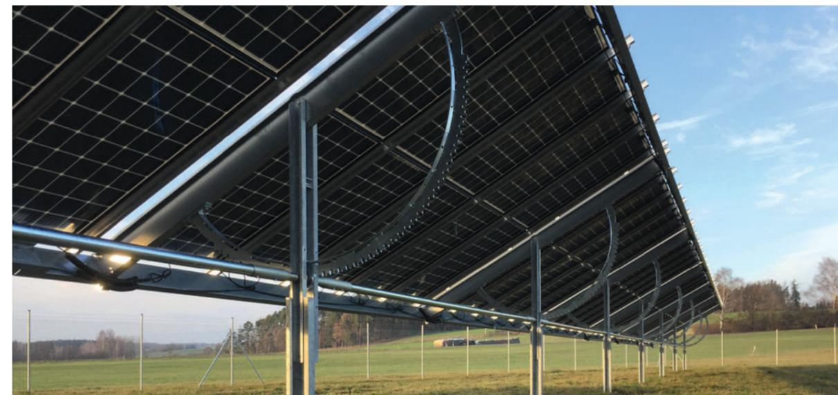
Doppelt hält besser: Die bifazialen Solarmodule nehmen das reflektierte Sonnenlicht über ihre Rückseite auf und sorgen so für einen deutlich höheren Energieertrag als herkömmliche Module.
